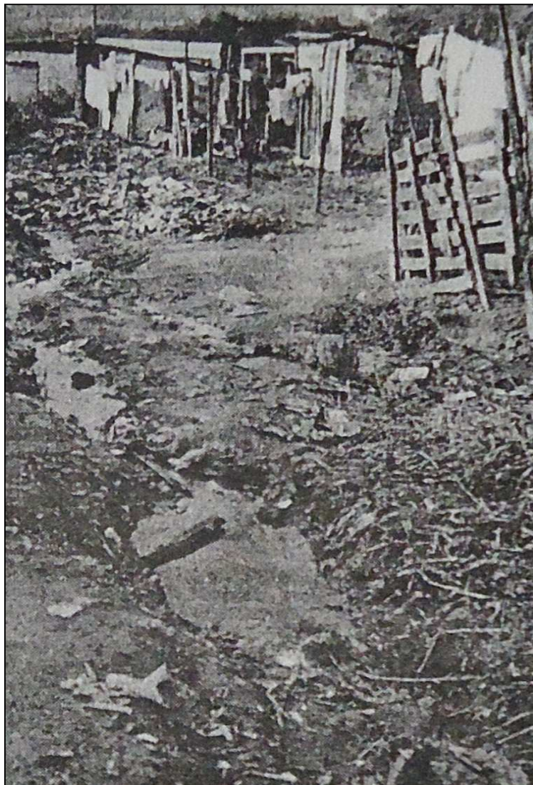
Figura 8 Esgoto em céu aberto da favela que ocorreu o despejo, na Rua Evolução.
