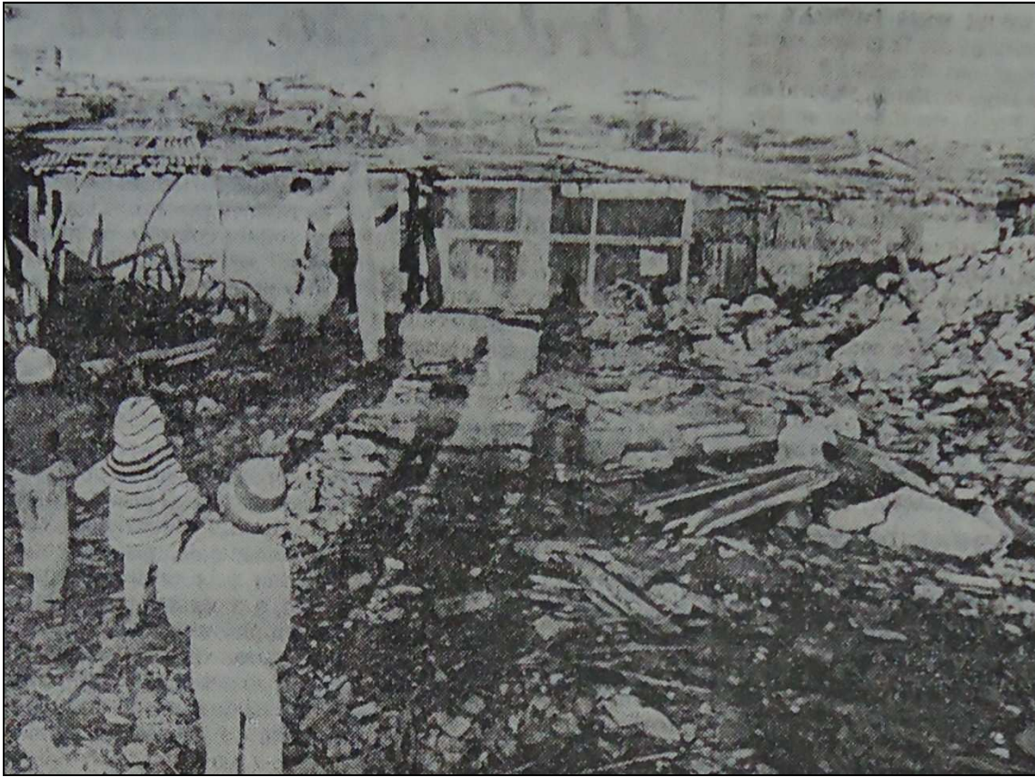
Figura 12 Barracos demolidos na Favela da Água Funda.
